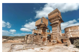
Fábrica Enxofre- Minas S. Domingos
